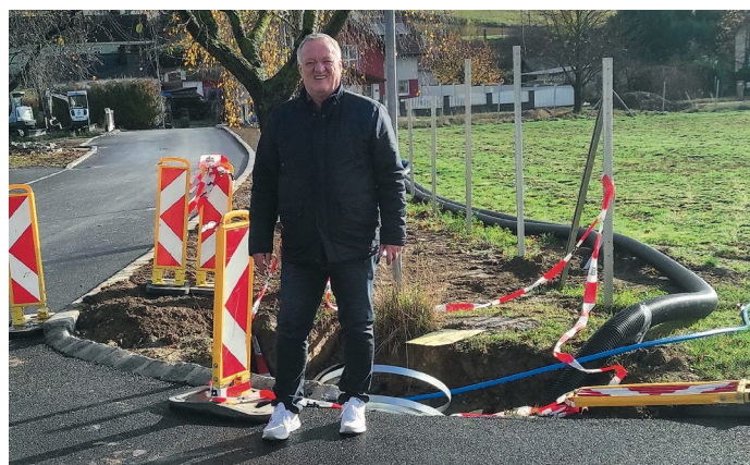
Der Bachweg in Eibesthal wurde fertiggestellt.
